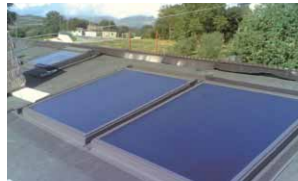
I collettori solari VELUX vengono installati contemporaneamente alle tegole. Nella foto sopra sono visibili due collettori affiancati e una finestra VELUX prima che le tegole vengano inserite.
